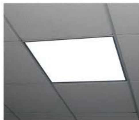
Los placas led de 60*60 se colocarán con ficha macho y hembra
